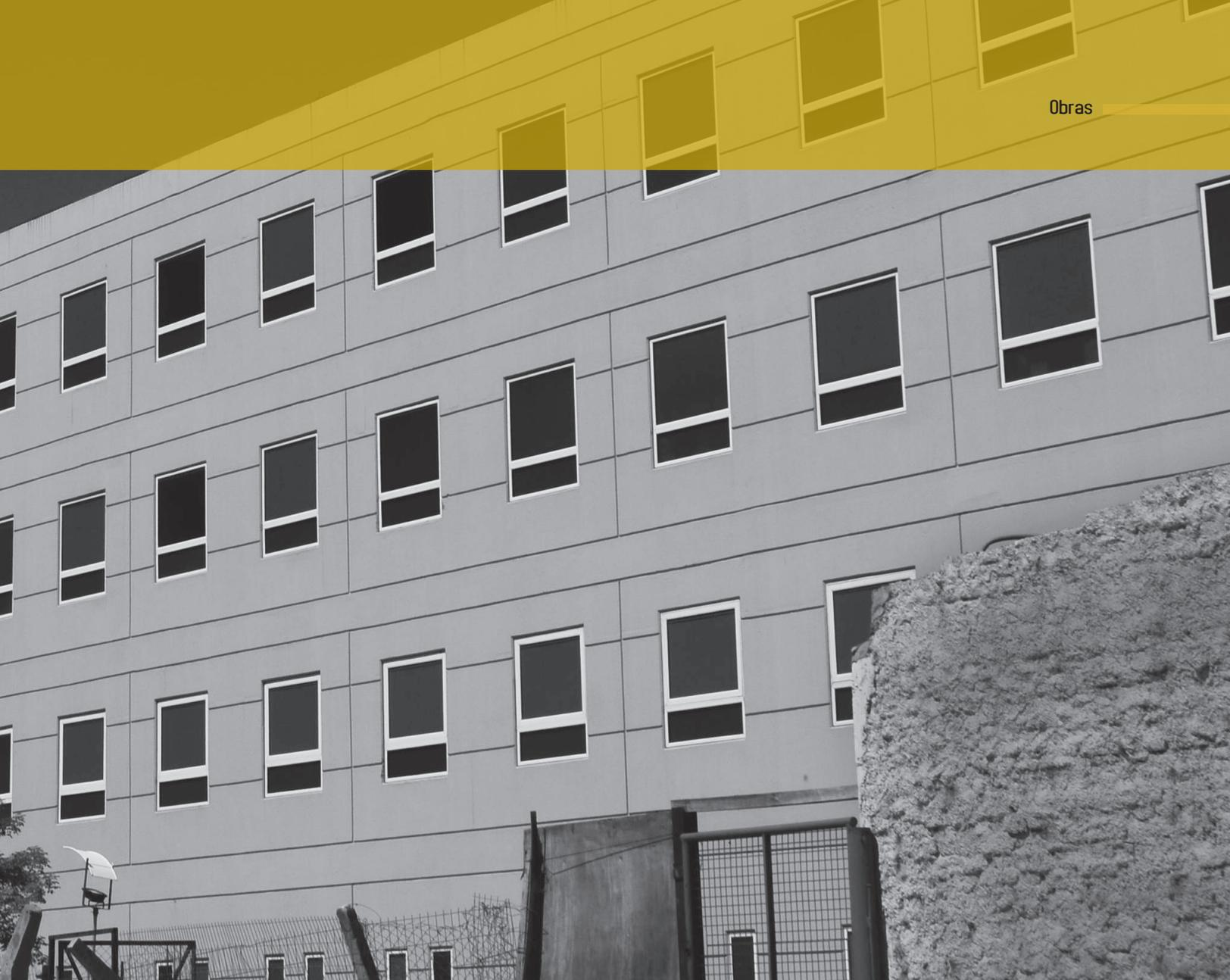
En el terreno de aproximadamente 3,5 ha, el proyecto contempla la construcción de un edificio monobloque simétrico de 70 m x 140 m. Consta de seis módulos o sectores, cinco de los cuales (los módulos 1, 2, 3, 4 y 6) son de cinco plantas, y un módulo (5) en dos plantas.
